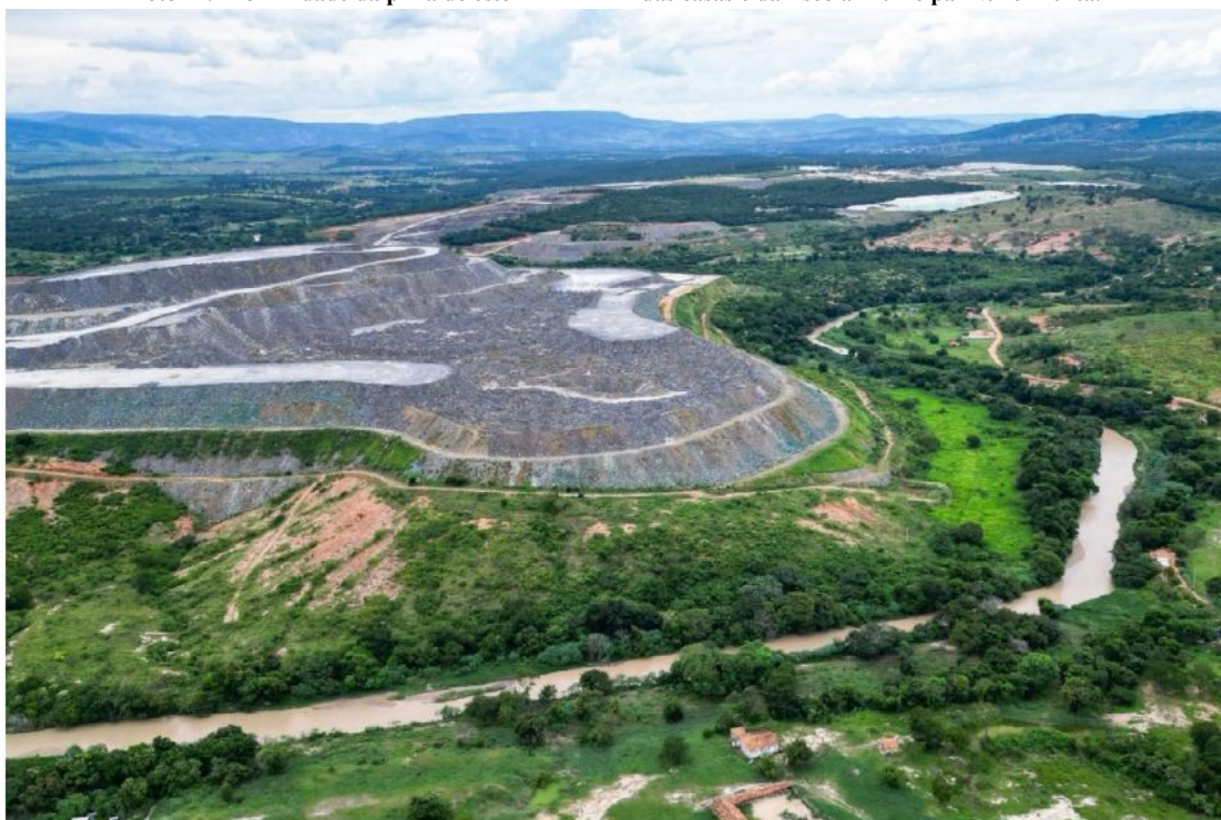
Foto 11: Proximidade da pilha de estéril – PDE4 – das casas e da Escola Municipal Nuno Murta.
