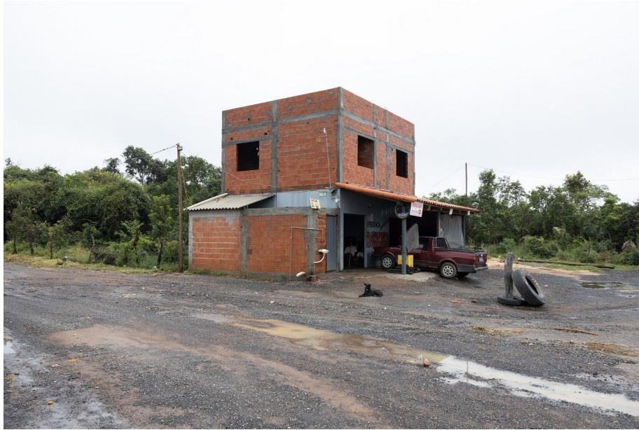
Precariedade das ligações de energia na Comunidade Vista Alegre.
