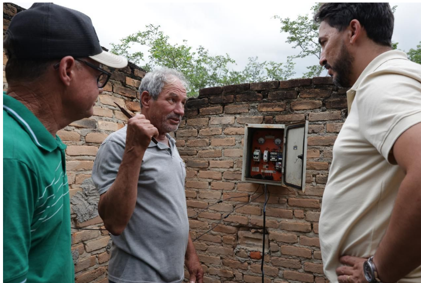
Verificação das condições da bomba do poço artesiano da Comunidade de Bamburral.
