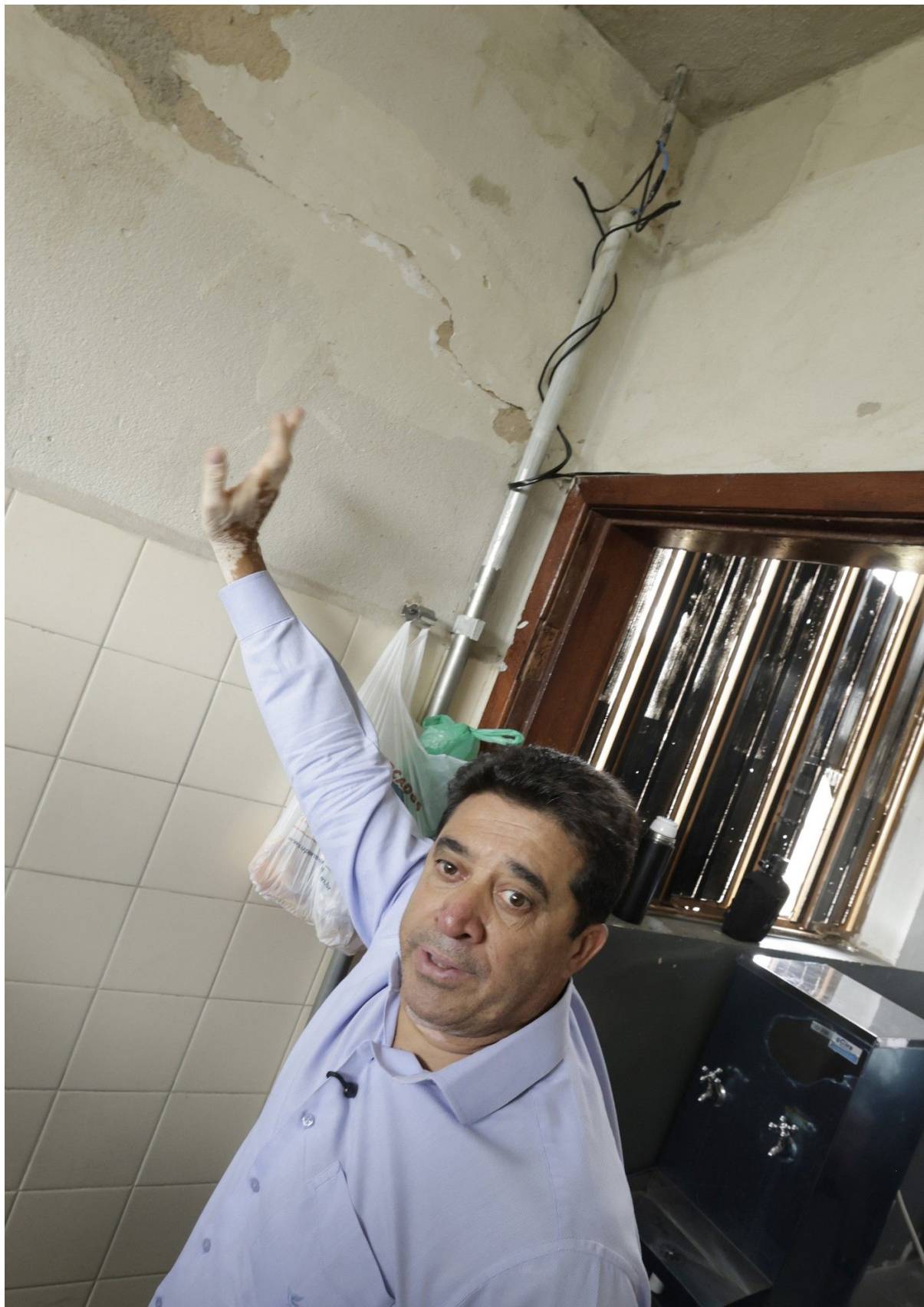
Parede, instalações elétricas e janelas
