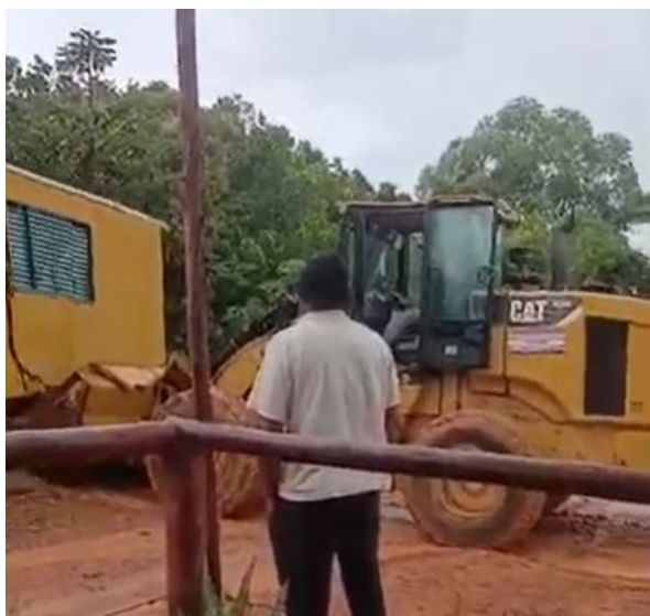
Imagem do vídeo recebido em 11/2 de demolição de alvenaria que teria ocorrido no mesmo dia
