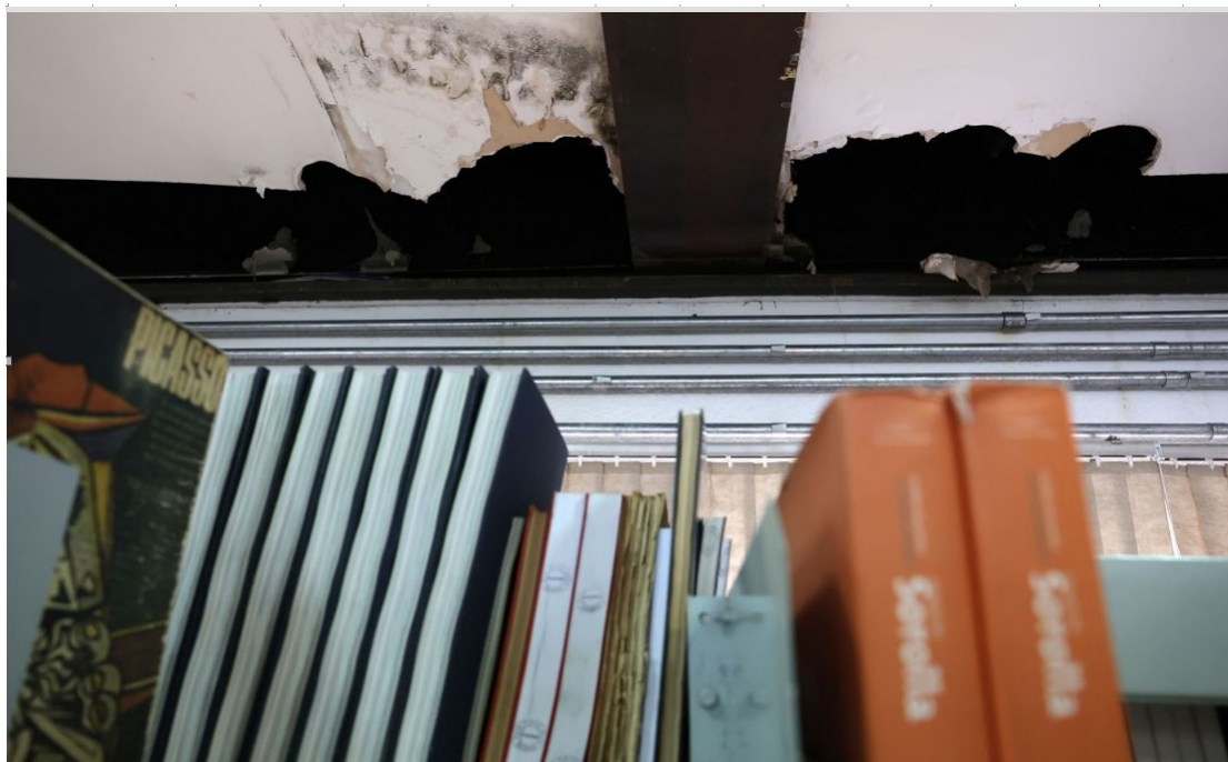
Buracos no teto, provocados por infiltração. Foto: Daniel Protzner/ALMG
