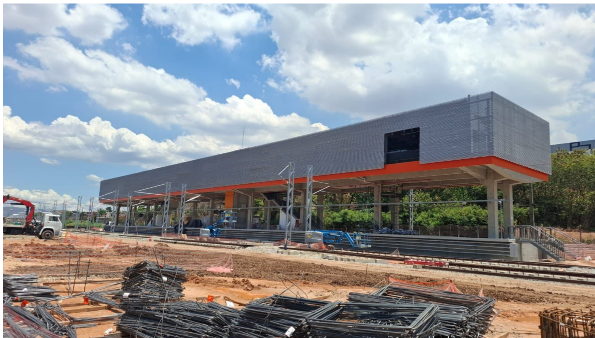
Foto 1 – Obras da Estação Novo Eldorado.
