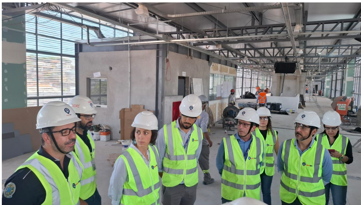
Foto 2 – Parte interna da obra.
