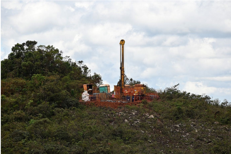
Equipamentos de perfuração do solo vistos desde a estrada.
