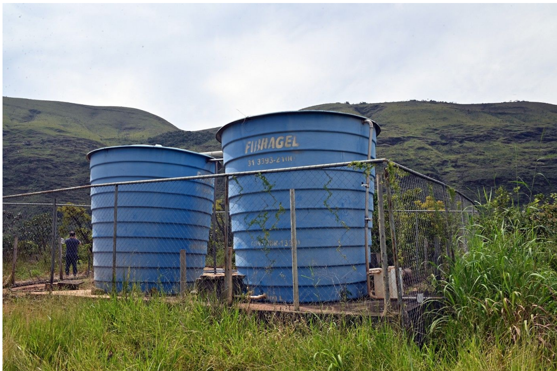
Caixas d'água que são abastecidas diariamente por caminhões-pipa
