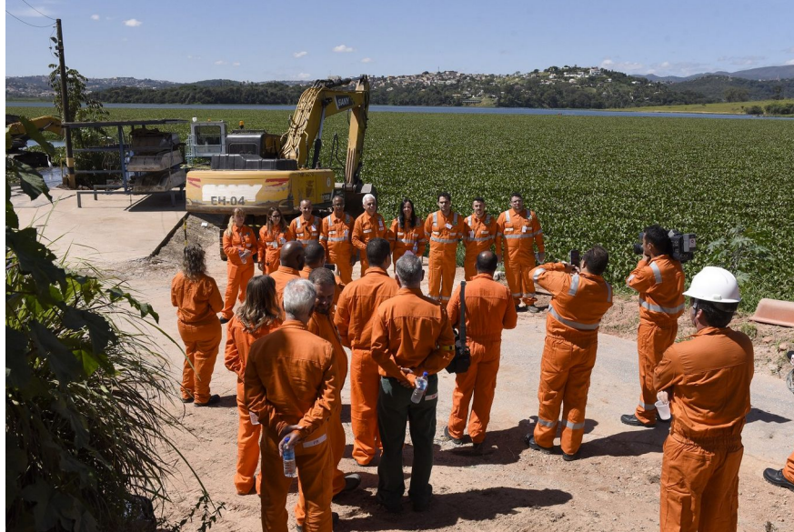
Retirada dos aguapés, no vertedouro da Lagoa de Ibirité
