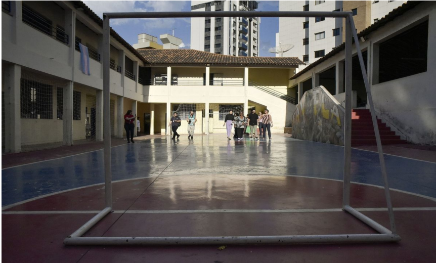
ASSEMBLEIA LEGISLATIVA DE MINAS GERAIS. Comissão de Educação, Ciência e Tecnologia – visita à Escola Estadual Augusto de Lima, em Belo Horizonte, 14/9/2023. Foto: Willian Dias. Quadra escolar, com destaque para a falta de cobertura.
