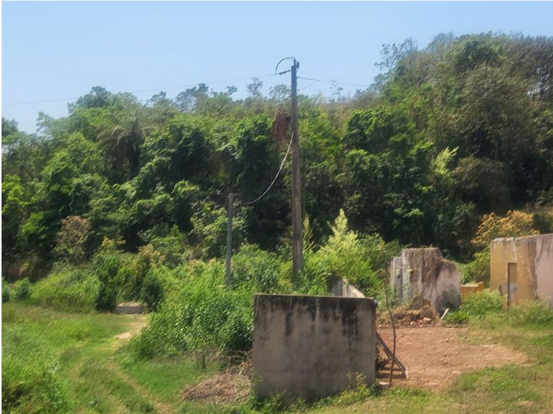
Poste de energia elétrica próximo à área em que as salas de aula foram construídas.
