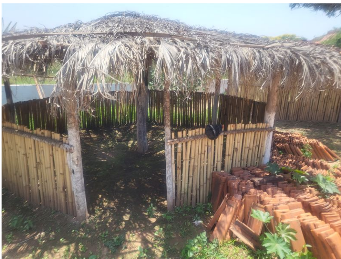
As telhas foram doadas à aldeia.
