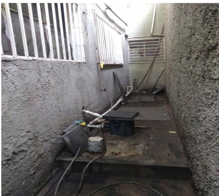
**Figura 5: Vista da parte de trás da cozinha, que apresenta odor de esgoto. A caixa de esgoto de toda unidade está atrás da janela da cozinha**
