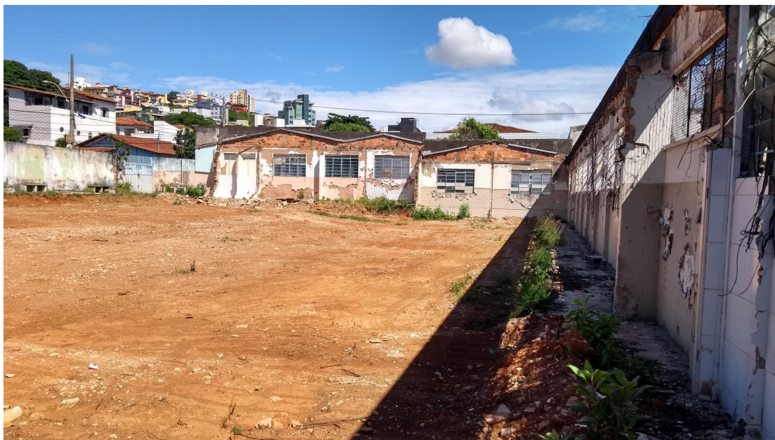
Figura 1. Terreno onde se localizava a Escola Estadual Alberto Delpino
