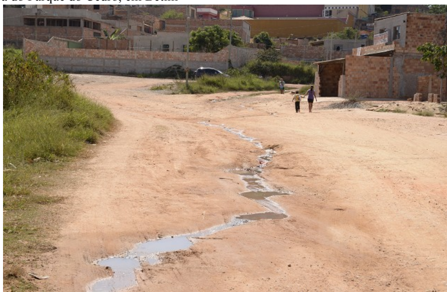
Figura 3: Esgoto correndo a céu aberto no Parque do Cedro
