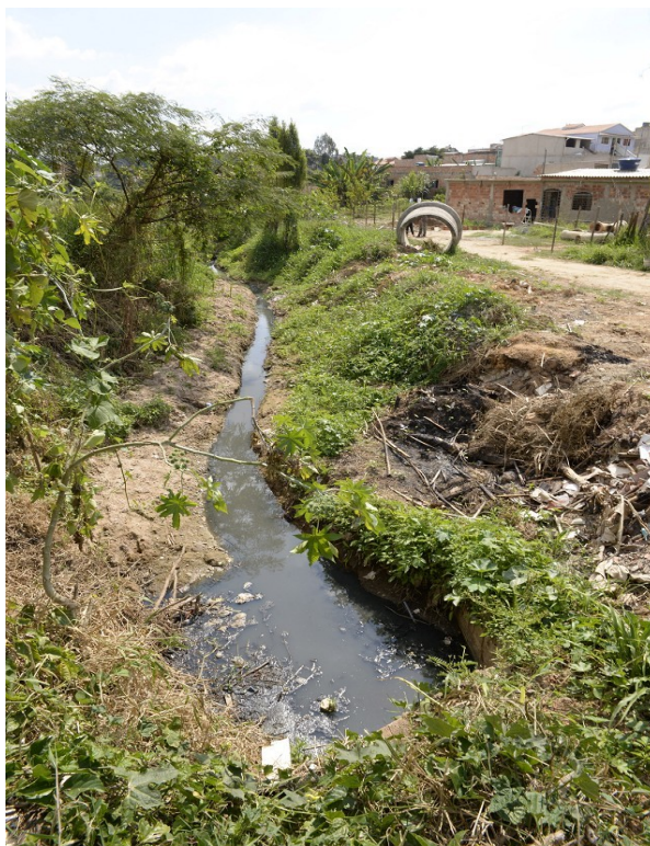
Figura 7: Ocupações irregulares em Área de Preservação Permanente ao longo do córrego do Bairro Recanto Nazaré
