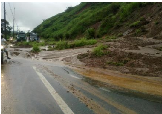
Figura 6 - Queda de barreira em Além Paraíba
