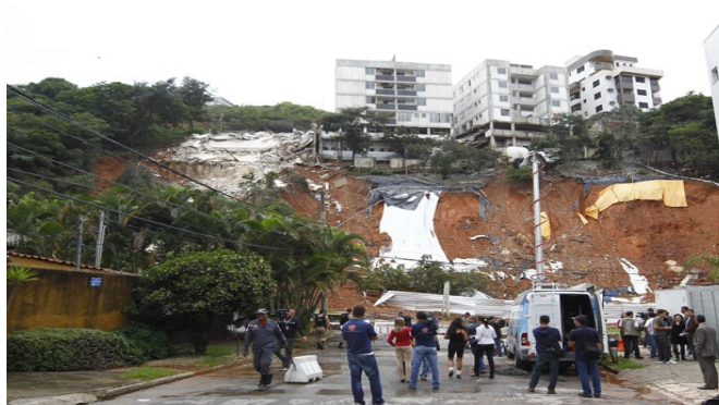
Figura 4 - Desabamento de edifício em Belo Horizonte
